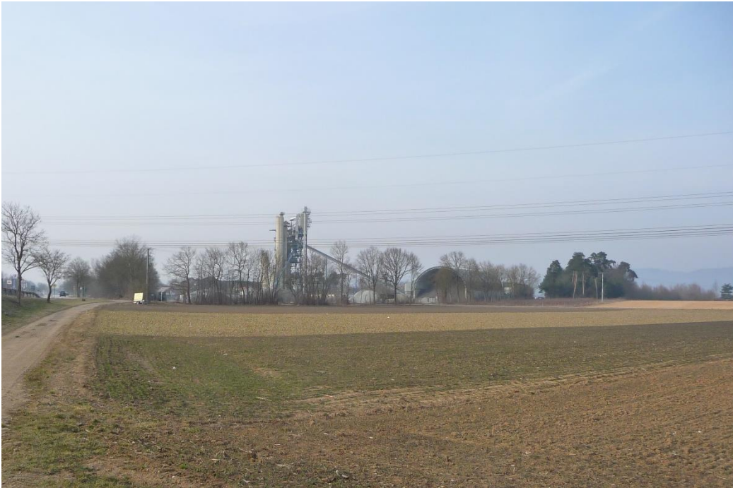
Vorbelastung aufgrund des Asphaltmischwerks und den Leitungen
